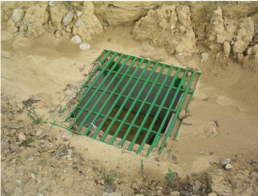
Fig. 7. Immagine del pozzetto e della grata di entrata dell'acqua, collegato con l'acquidoccio tubato.
