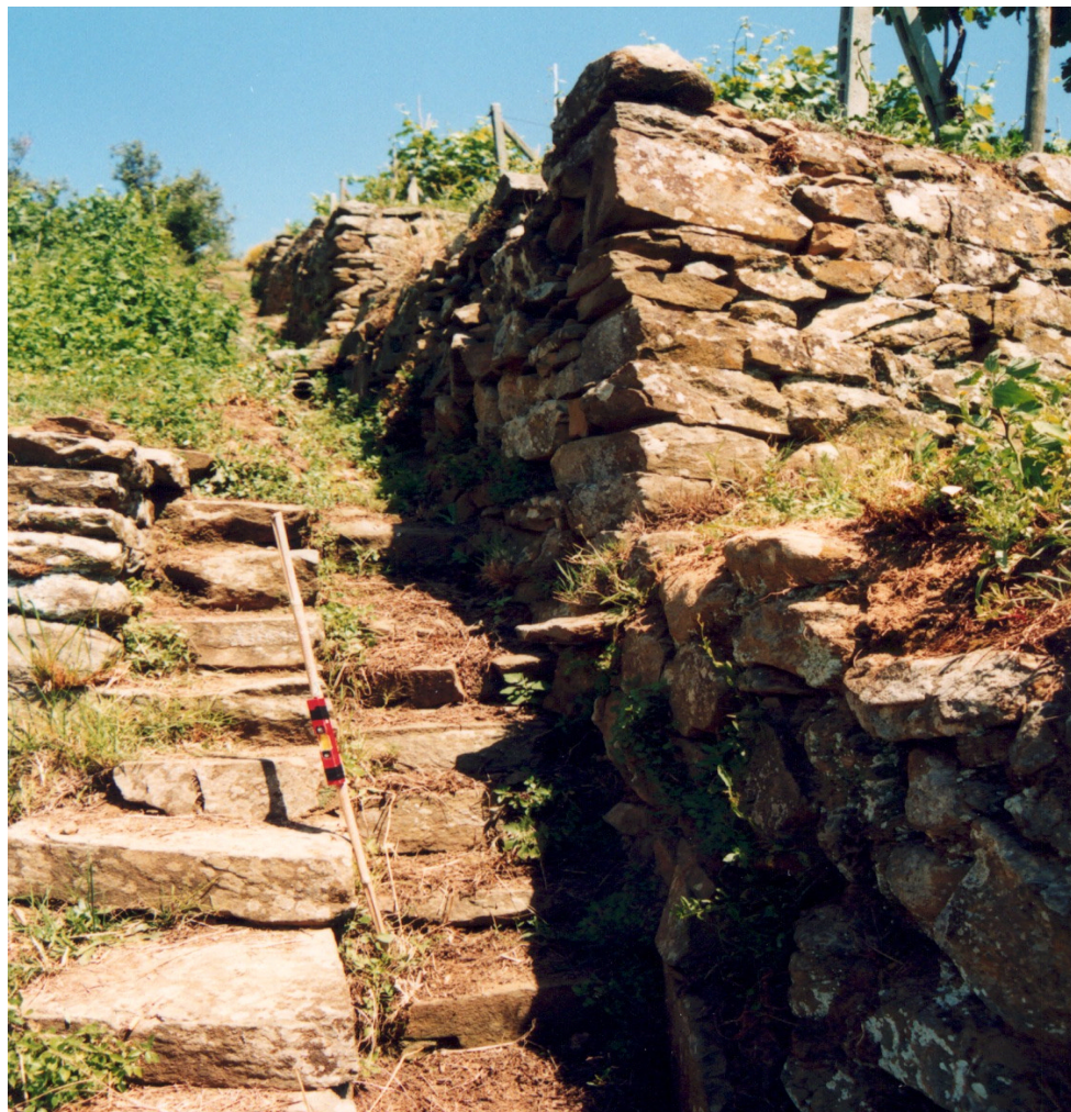
Fig. 12. Un magnifico esempio di acquidoccio “armato” a gradoni in un terrazzamento.
