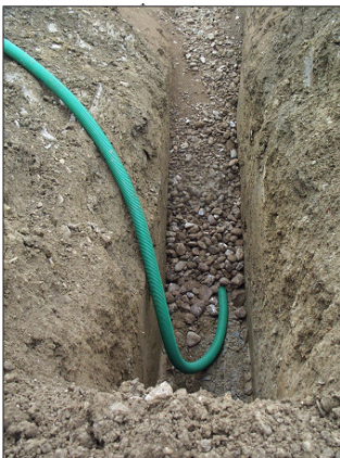
Fig. 13. Drenaggio tubato in uno strato di ghiaia.
