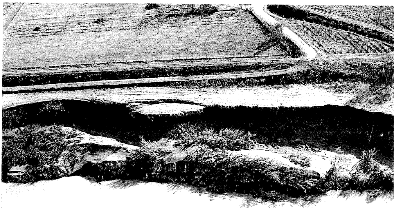
Erosione di sponda a valle di Empoli, in località Vitiana [14 novembre 1992 - Tav. 15A]
