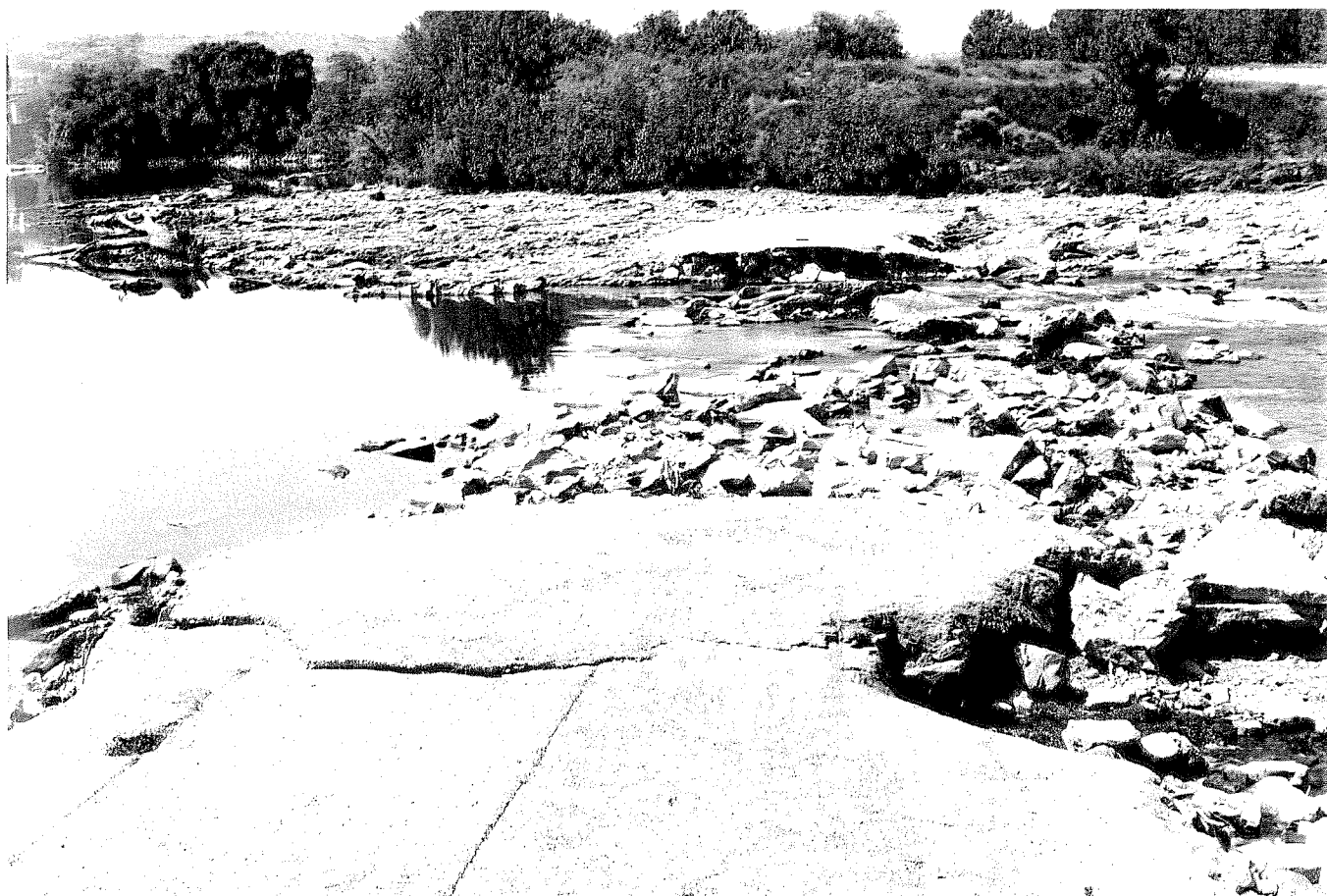
Traversa in località “Candeli” ad est di Firenze, distrutta dagli eventi di piena [26 maggio 1993 - Tav. 11 B].
