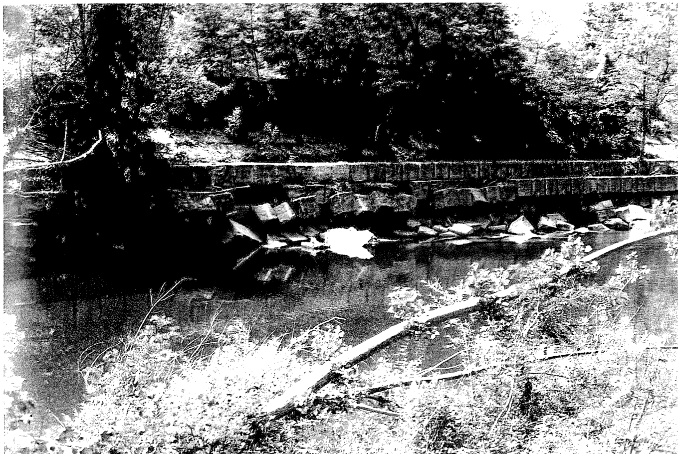
Difesa di sponda in prismi di calcestruzzo, fortemente danneggiata dall'erosione, presente nell'Arno a valle di Vado, due chilometri a monte del Ponte di Castelluccio, a sud di Capolona [7 giugno 1993 - Tav. 4 B].
