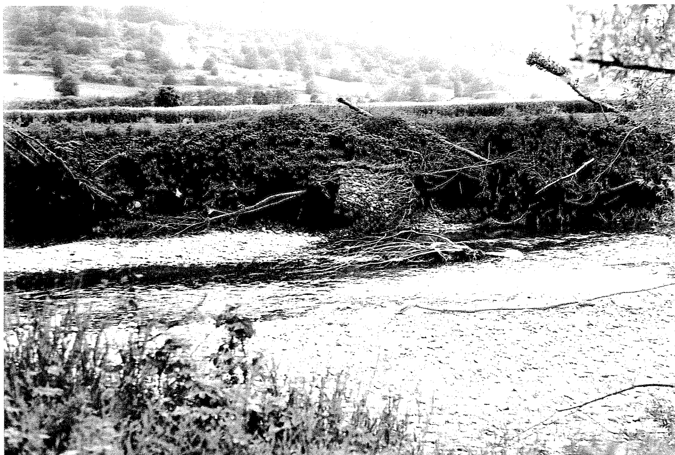
Erosione di sponda con pennello di gabbionate collassato e piante sradicate nell'alveo dell'Arno in Casentino (AR), in località Campaldino, presso Ponte a Poppi [10 giugno 1993 - Tav. 1 C].
