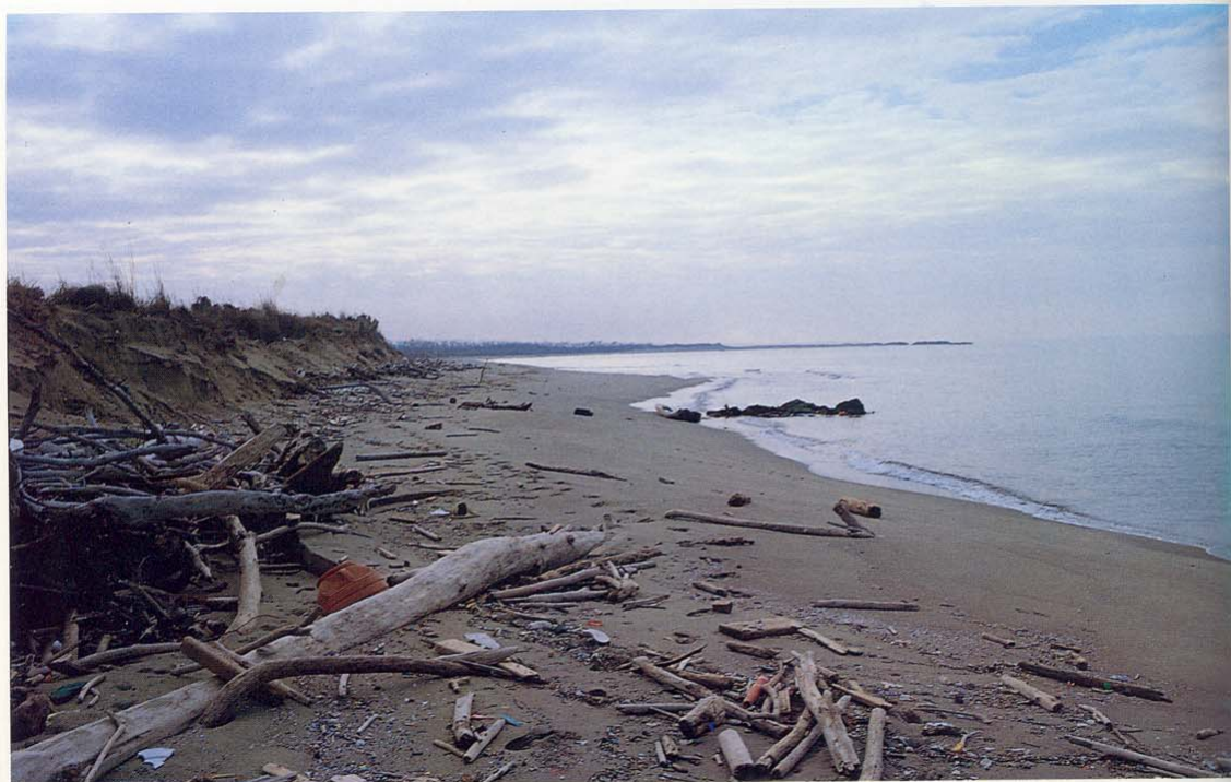
Zona a nord del Gombo nella Tenuta Presidenziale di S. Rossore (PI) - Si nota in primo piano lo scalzamento della duna, già completamente demolita nel tratto immediatamente a nord delle dighe a mare, visibili sullo sfondo.
