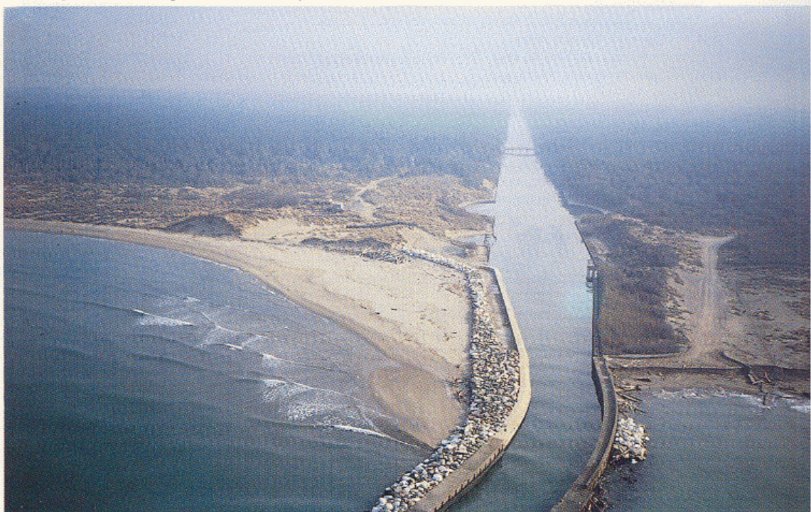
Bocca di Fiume Morto Nuovo (PI) - L'erosione si presenta sia a sud sia a nord delle opere murarie poste a difesa della foce. In particolare, in destra foto, si nota la demolizione avanzata di una "rotonda" in cemento armato ed in sinistra il "taglio" della duna per scalzamento al piede.
