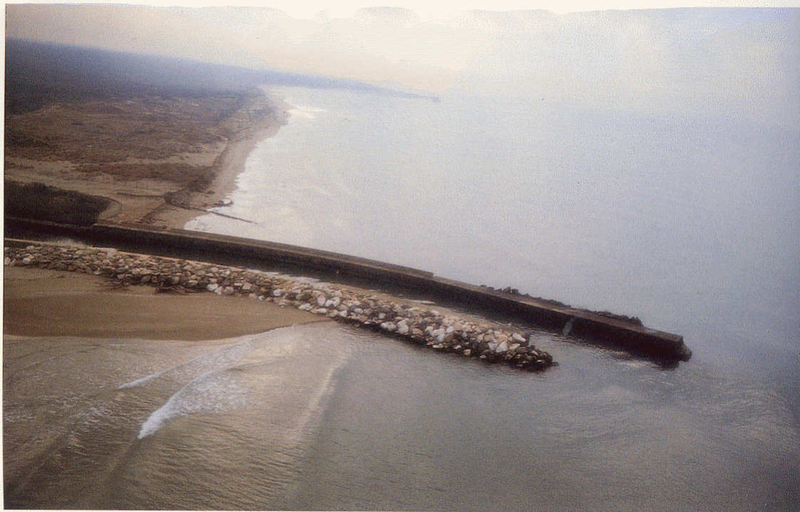
Tenuta Presidenziale di S. Rossore (PI) - Foce di Fiume Morto Nuovo. Si nota in alto la luna di erosione prodotta dalle dighe del "Gombo" con lo scalzamento della duna e delle opere in primo piano.
