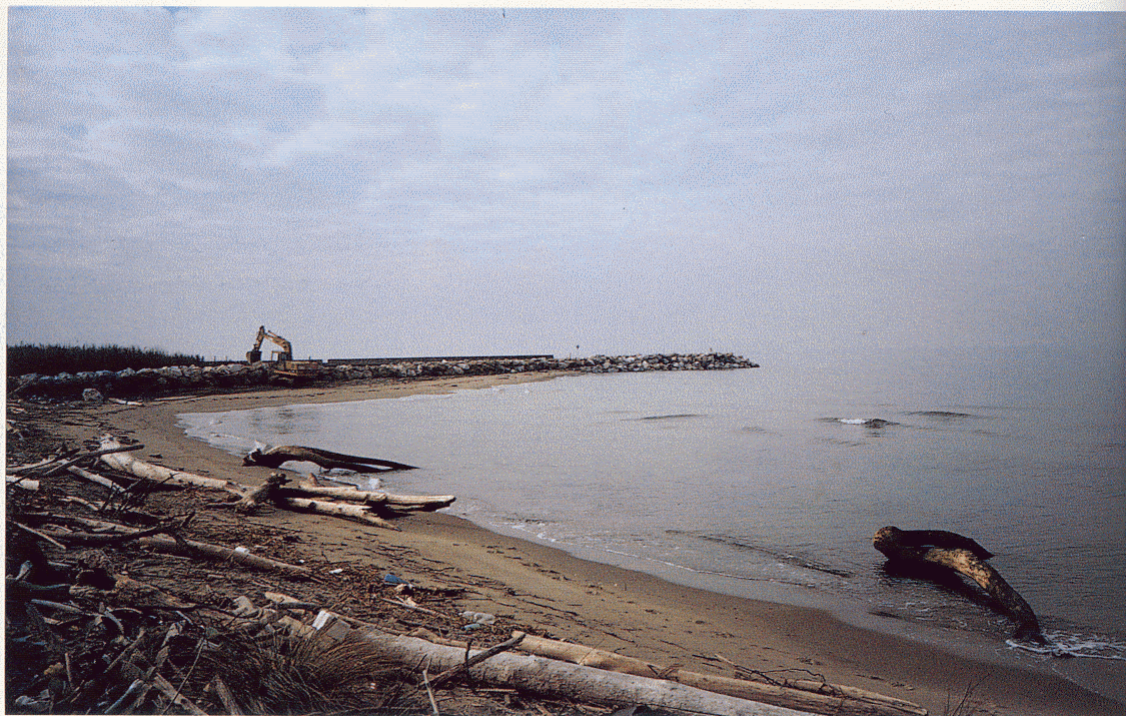
Tenuta Presidenziale di S. Rossore (PI) - Bocca di Fiume Morto Nuovo. Opere di consolidamento dei manufatti posti a difesa della Foce, con evidente luna di erosione in primo piano.
