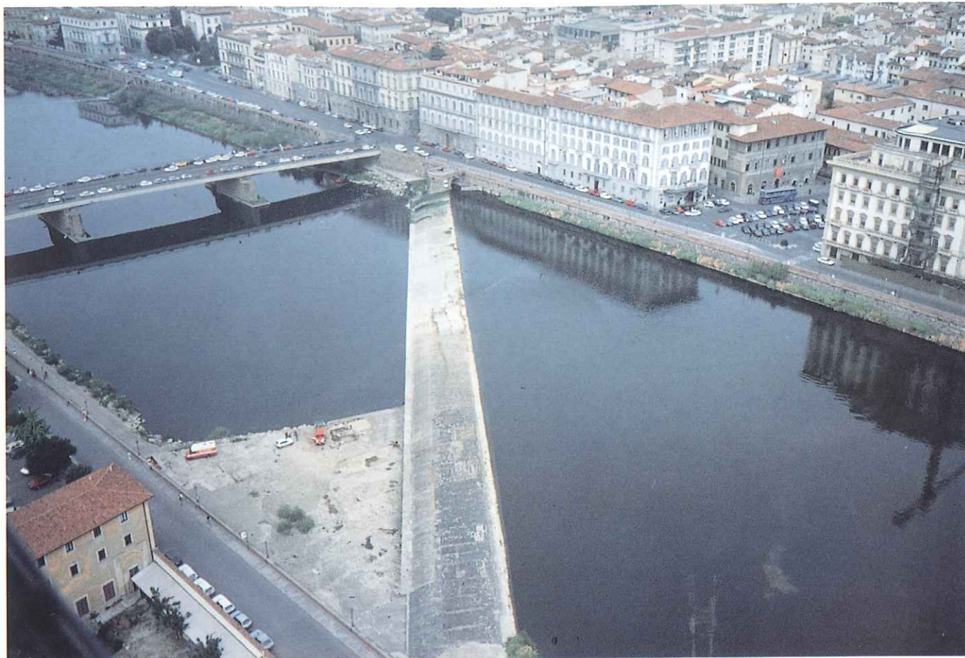
Portate di magra dell'Arno - Il fiume alla Pescaia di Santa Rosa in Firenze (26 Settembre 1992). L'Arno, nel periodo Luglio-fine Settembre, si mantiene spesso su portate estremamente basse (ad es. 3 \div 4 \text{ m}^3/\text{s} alla sezione degli Uffizi), molto al di sotto della "portata minima vitale", stimata in 8 \text{ m}^3/\text{s} . L'acqua del fiume diventa uno specchio immobile.
