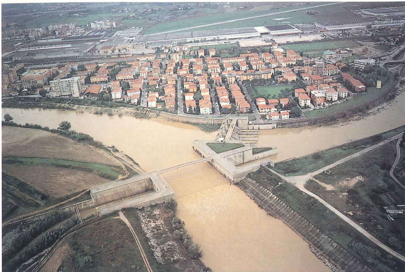
Interventi recenti di difesa idraulica - L'Arno e l'opera di presa dello Scolmatore a Pontedera, dopo l'evento alluvionale dell'ottobre 1993. Il canale, completato dopo l'alluvione del 1966, è attualmente in grado di smaltire portate di piena di circa 1.000 m 3 /s, che sono convogliate direttamente al mare. Esso contribuisce alla messa in sicurezza della città di Pisa e degli abitati a valle di Pontedera.
