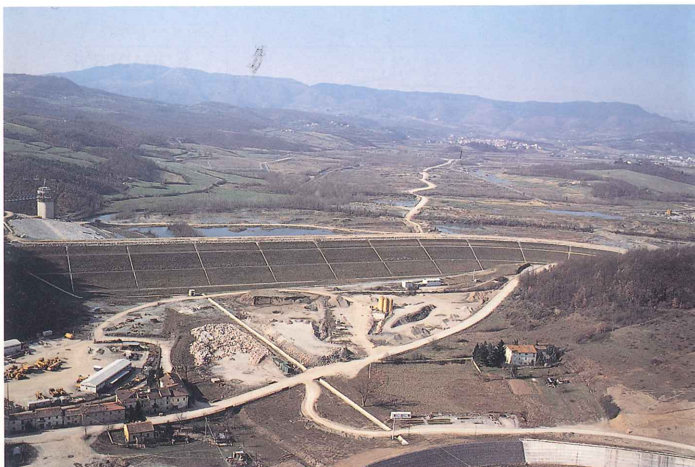
Interventi recenti di difesa idraulica - Invaso di Bilancino sul fiume Sieve in una foto del 1994. La diga, in materiali sciolti, alta 42 m, con uno sviluppo del coronamento di 720 m, ha un volume di invaso complessivo di 84 milioni di metri cubi, 15 dei quali utili per laminare le piene dell'alta Val di Sieve. Contribuirà inoltre alla regolazione estiva della Sieve e dell'Arno a valle di Firenze, al raggiungimento della "portata minima vitale" del fiume e all'approvvigionamento idrico del comprensorio fiorentino. L'opera è, oggi, in fase di completamento.
