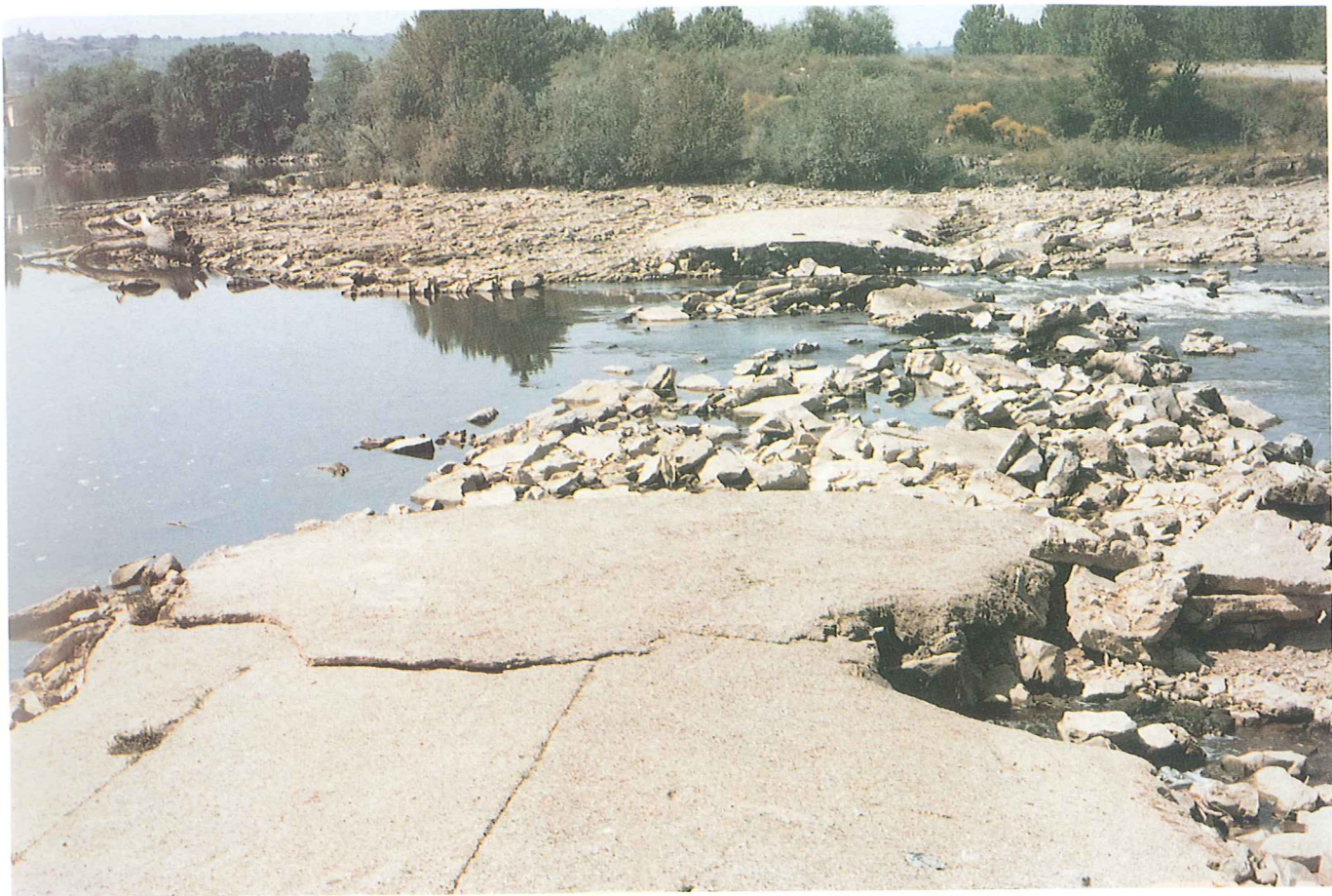
Manutenzione delle opere in alveo - Lungo il corso dell'Arno sono frequenti danneggiamenti a traverse e OO.II, come quelli figurati in loc. "Candeli", ad est di Firenze (sopra) e presso il Mulino di Incisa Valdarno (Firenze) (sotto).
