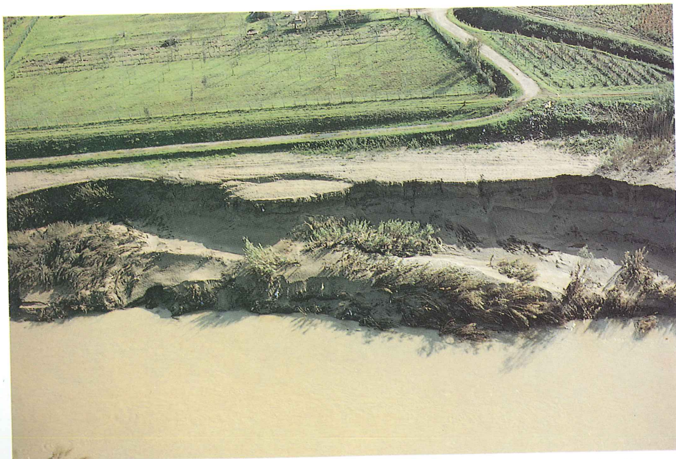
Manutenzione e sistemazione degli alvei - Erosione di sponda lungo l'Arno a valle di Empoli, in loc. "Vitiana", dopo l'intervento alluvionale dell'Ottobre - Novembre 1992.
