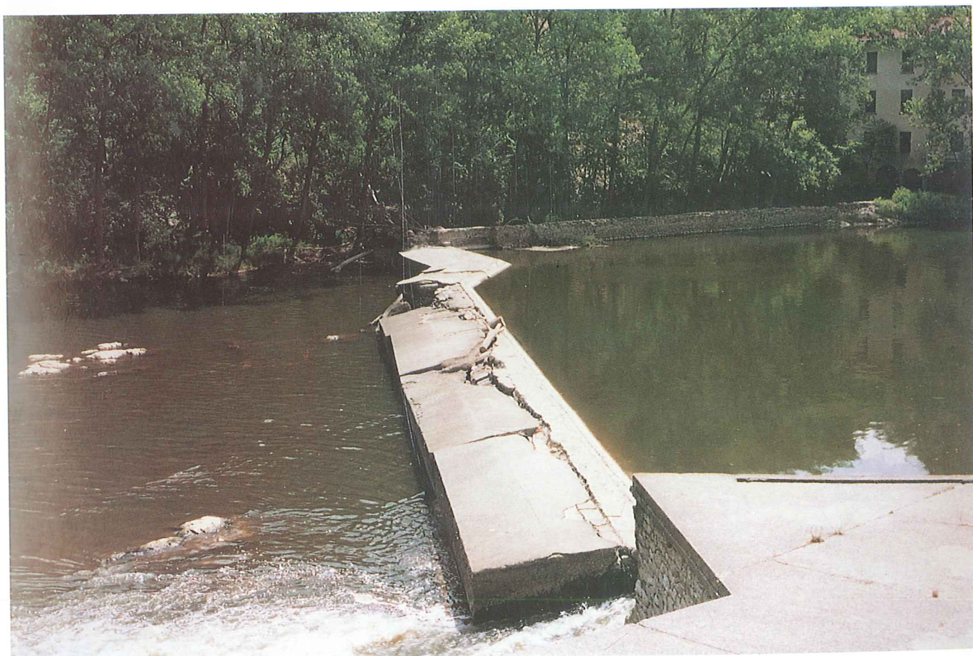
Manutenzione delle opere in alveo - Lungo il corso dell'Arno sono frequenti danneggiamenti a traverse e OO.II, come quelli figurati in loc. "Candeli", ad est di Firenze (sopra) e presso il Mulino di Incisa Valdarno (Firenze) (sotto).
