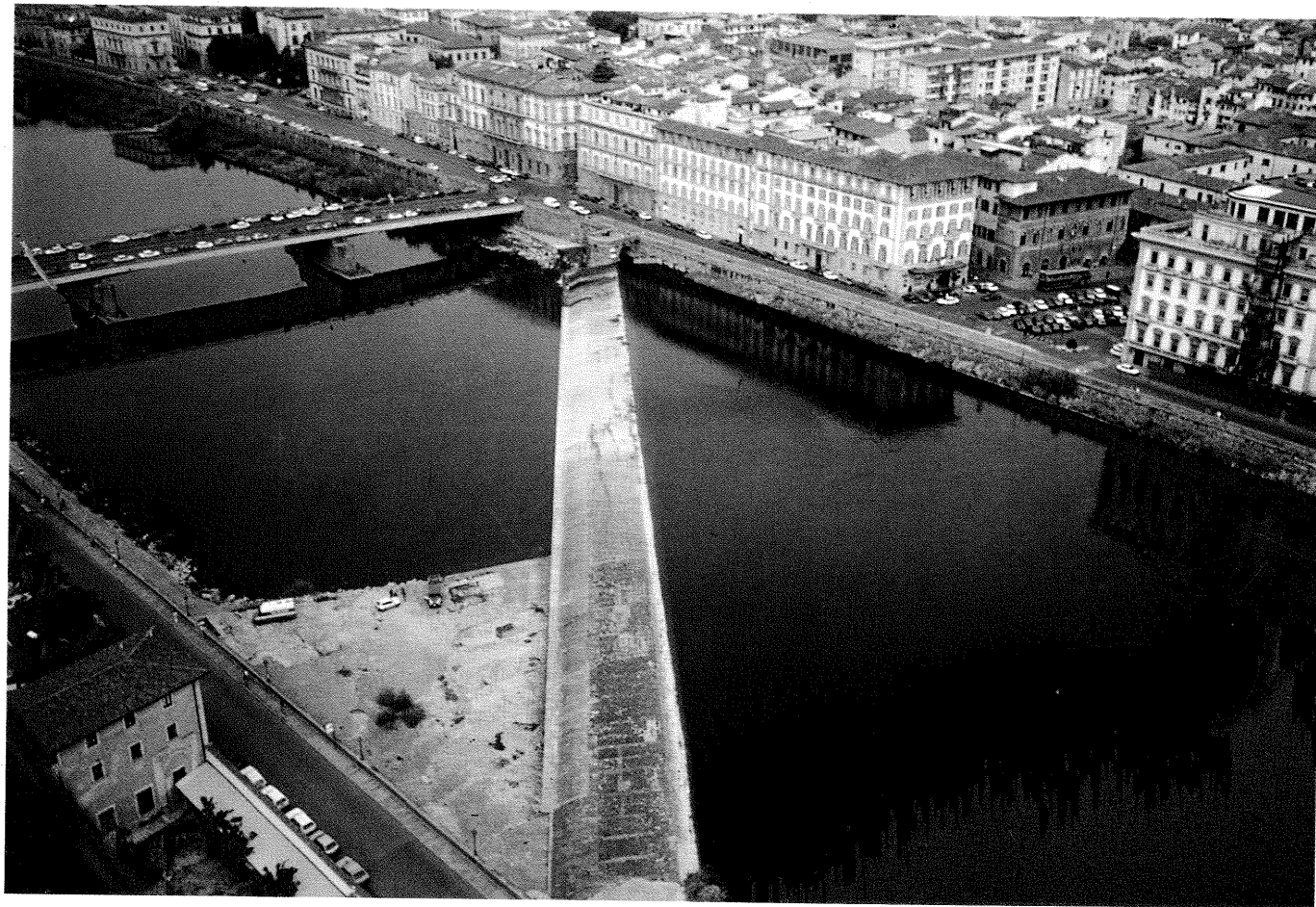
Portate di magra dell'Arno - Il fiume alla Pescaia di Santa Rosa in Firenze (26 Settembre 1992). L'Arno, nel periodo Luglio-fine Settembre, si mantiene spesso su portate estremamente basse (ad es. 3 \div 4 \text{ m}^3/\text{s} alla sezione degli Uffizi), molto al di sotto della "portata minima vitale", stimata in 8 \text{ m}^3/\text{s} . L'acqua del fiume diventa uno specchio immobile.
