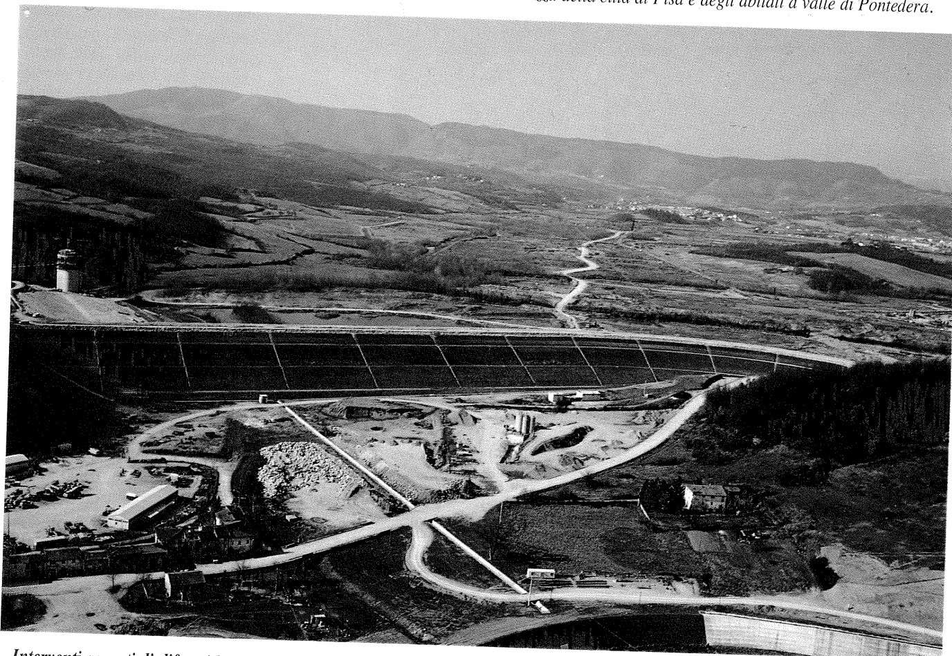
Interventi recenti di difesa idraulica - Invaso di Bilancino sul fiume Sieve in una foto del 1994. La diga, in materiali sciolti, alta 42 m, con uno sviluppo del coronamento di 720 m, ha un volume di invaso complessivo di 84 milioni di metri cubi, 15 dei quali utili per laminare le piene dell'alta Val di Sieve. Contribuirà inoltre alla regolazione estiva della Sieve e dell'Arno a valle di Firenze, al raggiungimento della "portata minima vitale" del fiume e all'approvvigionamento idrico del comprensorio fiorentino. L'opera è, oggi, in fase di completamento.
