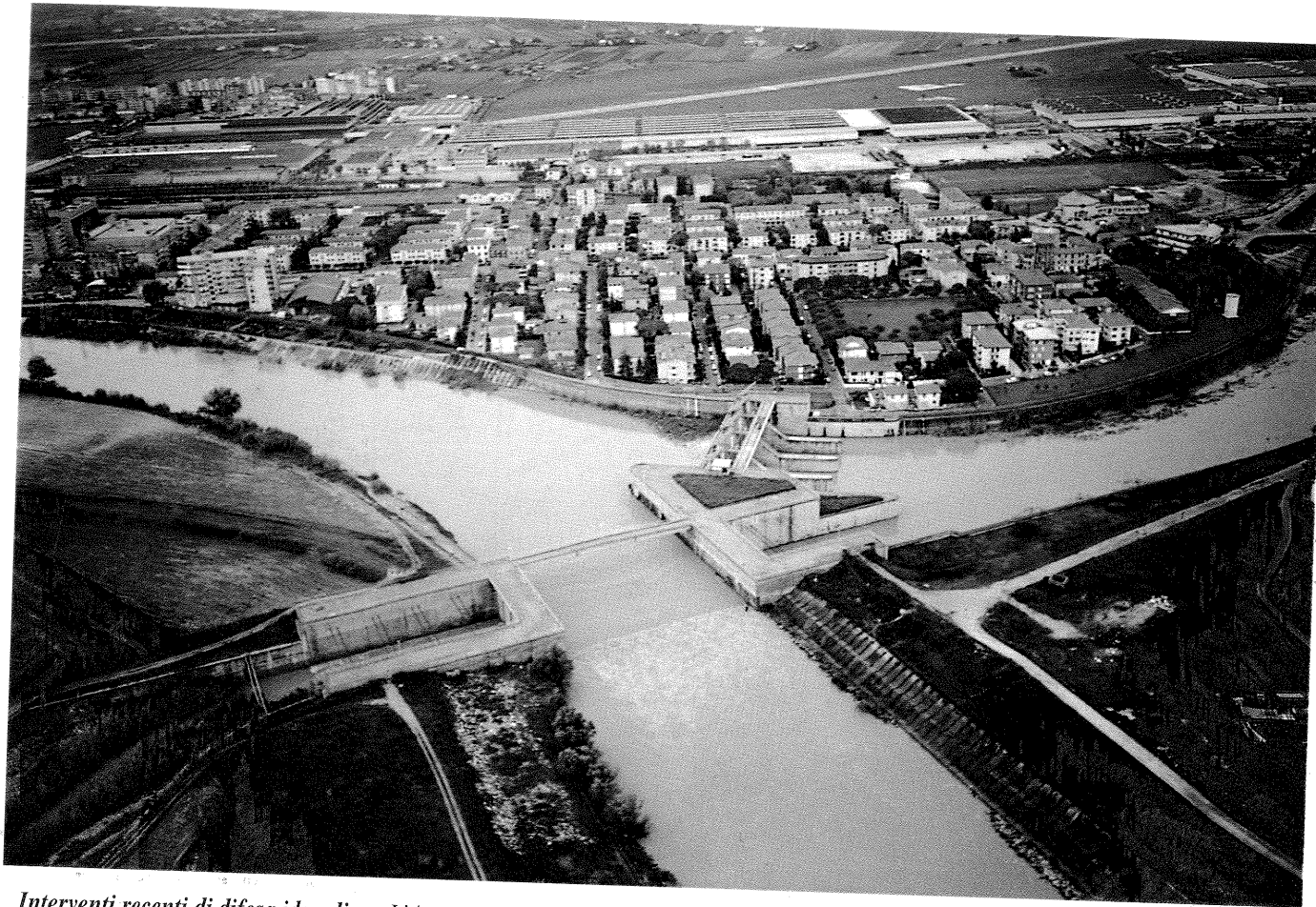
Interventi recenti di difesa idraulica - L'Arno e l'opera di presa dello Scolmatore a Pontedera, dopo l'evento alluvionale dell'ottobre 1993. Il canale, completato dopo l'alluvione del 1966, è attualmente in grado di smaltire portate di piena di circa 1.000 m 3 /s, che sono convogliate direttamente al mare. Esso contribuisce alla messa in sicurezza della città di Pisa e degli abitati a valle di Pontedera.
