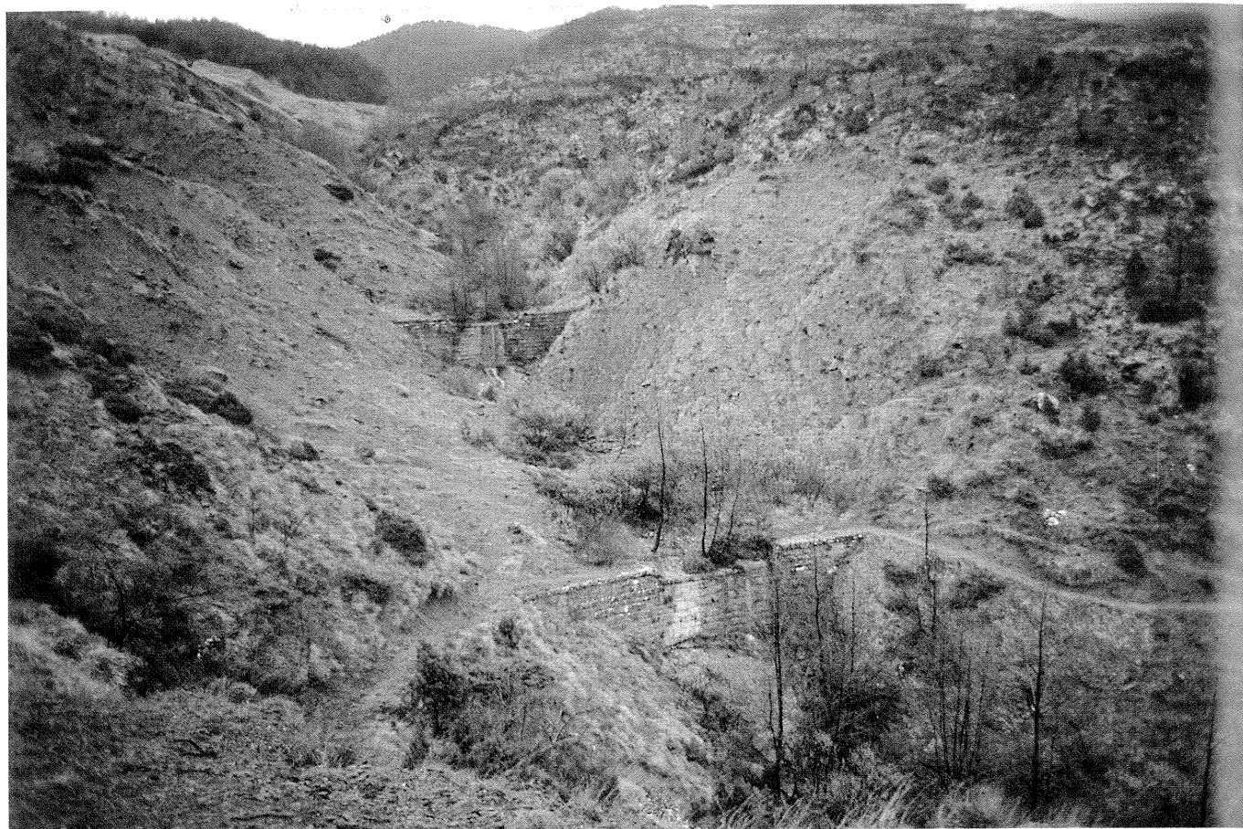
Sistemazioni idraulico-forestali e di difesa del suolo nelle aree montane - Esempi di “briglie”, ben inserite nell’ambiente montano naturale, lungo un fosso minore del Falterona (in alto) e nell’alveo di un torrente del Casentino (in basso). Le opere di correzione dei corsi d’acqua montani erano il risultato di interventi organici sui bacini montani, iniziati nella prima metà dell’Ottocento e sviluppati nei primi decenni di questo secolo.
