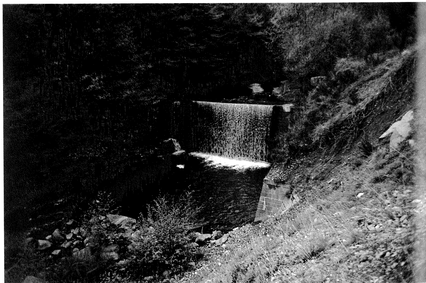
Dagli anni Sessanta si è assistito a una progressiva perdita di efficacia degli interventi; a livello di bacino sono state censite oltre 2.700 briglie, delle quali oggi circa 900 presentano danni medio-gravi e oltre 700 risultano parzialmente danneggiate (foto S. Grazi).
