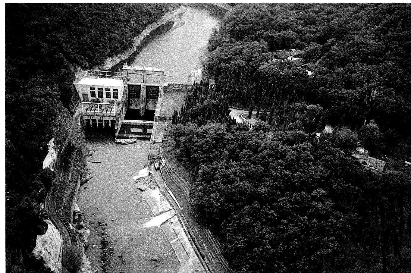
La diga ENEL di Levane (capacità totale di invaso 4,9 milioni di mc - capacità utile 3,5 milioni di mc) e lo scarico di acqua in Arno il 26 settembre 1992, valutato in circa 1,5-2 mc/s. L'interrimento è pari a 1,5 milioni di mc.
