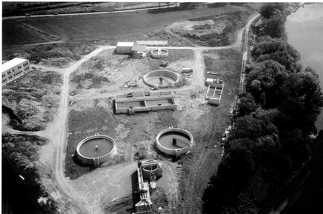
Il depuratore consortile di Pontassieve (Le Sieci) in costruzione sulla riva destra dell'Arno (1° lotto, 18.000 abitanti equivalenti).
