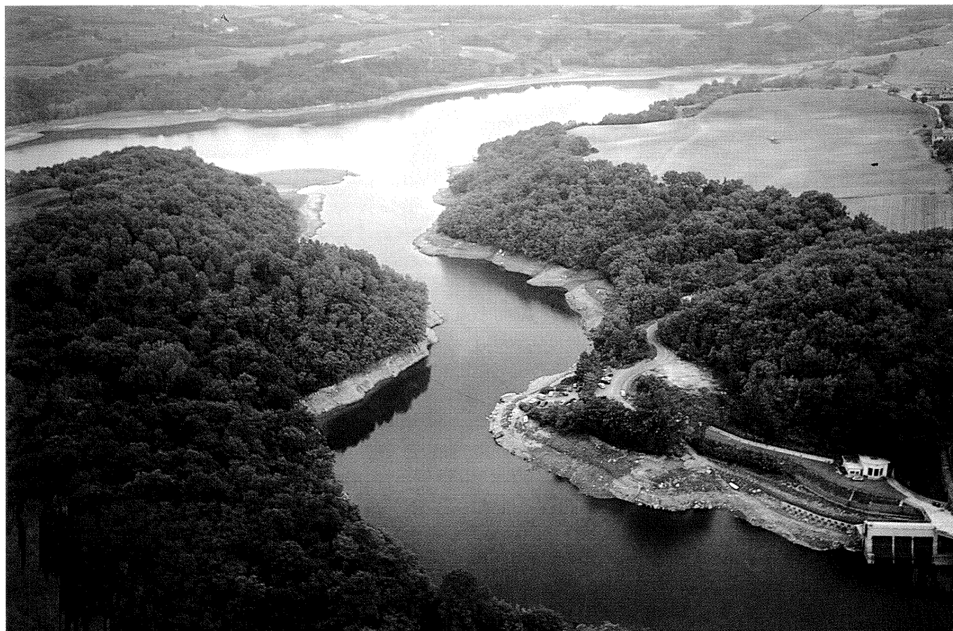
L'invaso ENEL di La Penna, lungo l'Arno a monte di Montevarchi (AR), il 26 Settembre 1992 durante il periodo di siccità illustrato. L'impianto avrebbe una capacità totale di 16 milioni di mc (capacità utile di 9,8 milioni di mc), ma è interessato da un avanzato processo di interrimento (4,5 milioni di mc).
