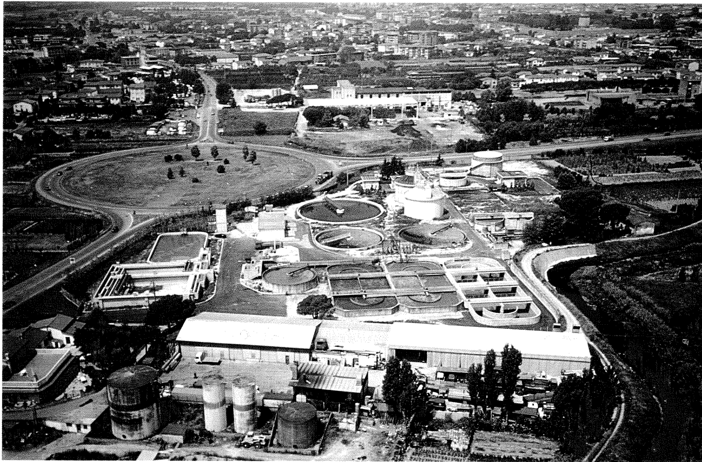
Depuratore comunale di Pistoia, lungo il torrente Brana in località Fagiolo, con depurazione pari a 60.000 abitanti equivalenti.
