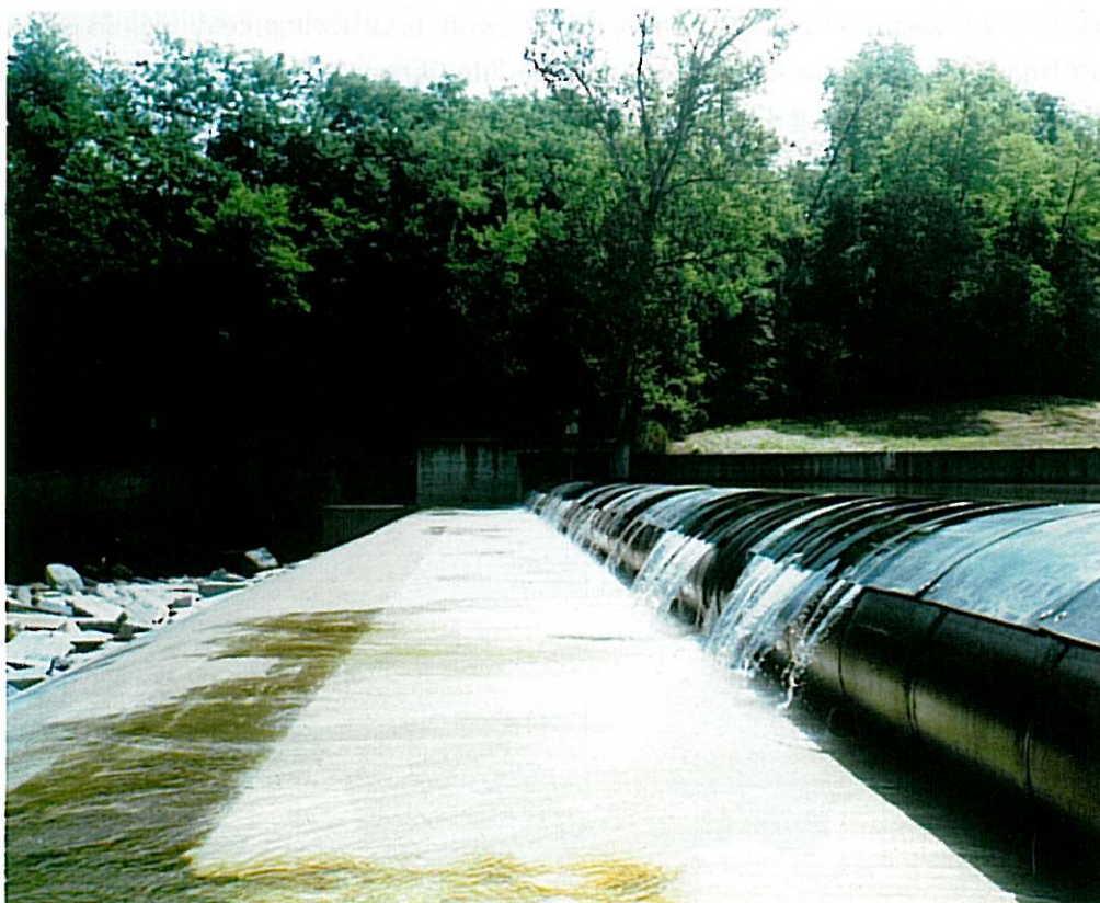
Figura 18 Traversa gonfiabile tracimata (Jollytech s.a.s.).
