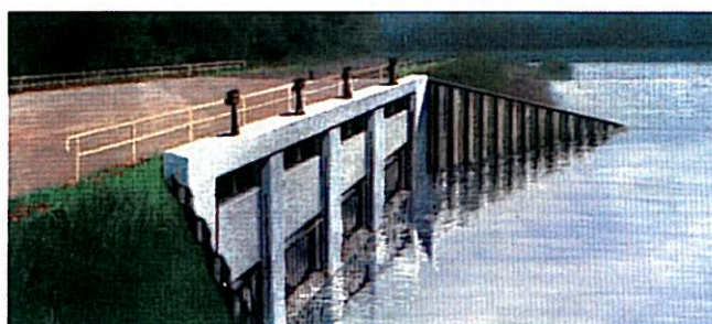
Figura 19 esempio di manufatto idraulico di alimentazione che interrompe l'argine (Polder d'Erstein; V.N.F.)
