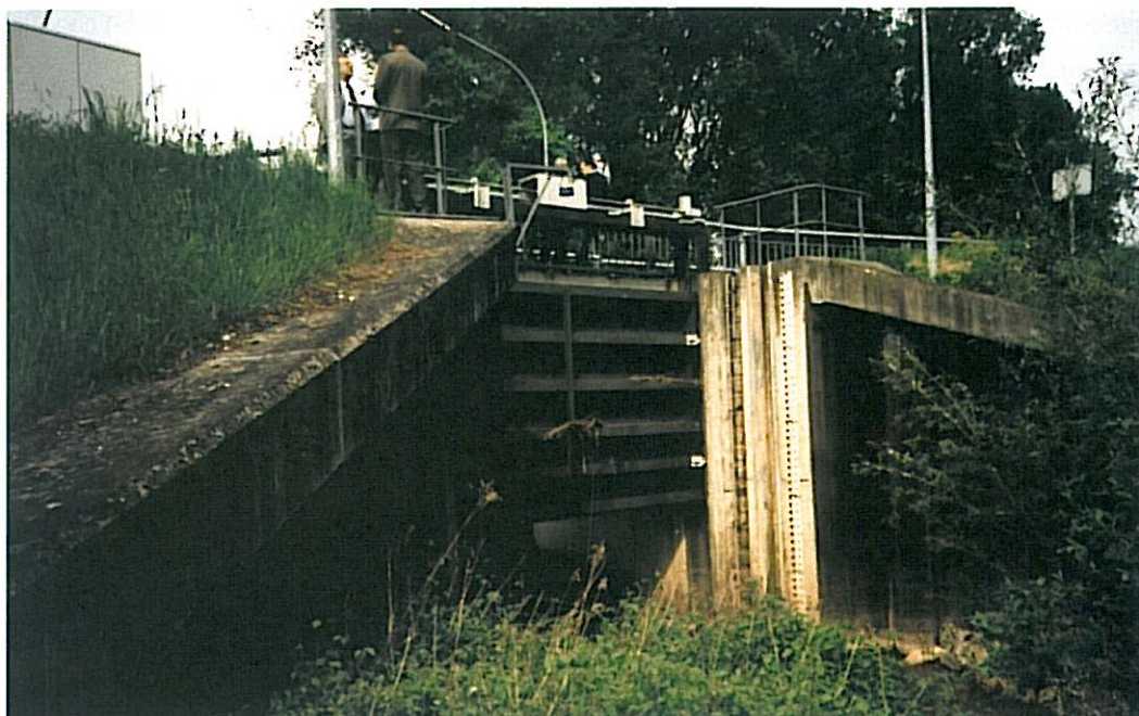
Figura 24 Manufatto idraulico di scarico che interrompe l'arginatura (Polder de La Moder)
