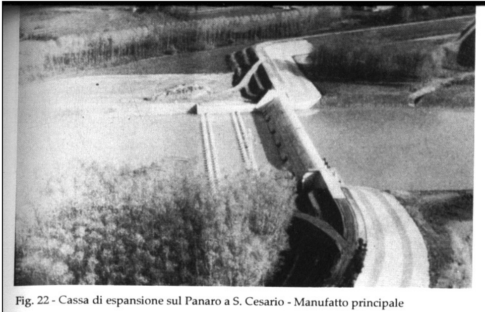
Figura 19 Sfioratore laterale (da Baroncini, 1995)
