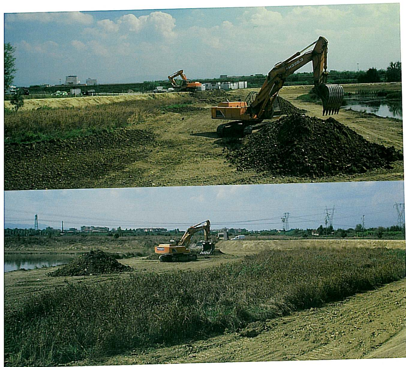
Fig. 121 e 122 Zona umida Casa Passerini: lavori di ampliamento della cassa di espansione e realizzazione di nuovi isolotti (2002).
