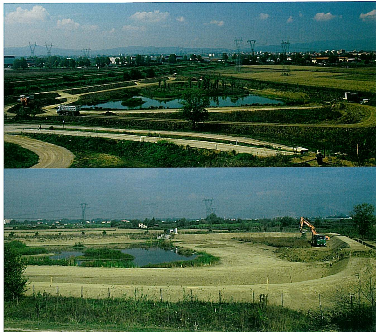
Fig. 118 e 119 Zona umida Casa Passerini: lavori di ampliamento della cassa di espansione e realizzazione di nuovi isolotti (2002).
