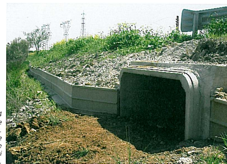
Fig. 44 Imboccatura di un sottopasso (tombino a sezione quadrangolare) per il passaggio della fauna minore. Si notano anche le barriere antiattraversamento che convergono verso l'imboccatura. Strada Provinciale 'Vignarca' nel tratto prospiciente l'Oasi WWF Orti Bottagone, Piombino, Livorno (anno 2006).
