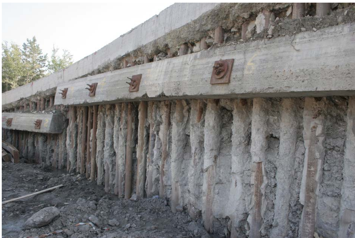
Fig. 81 – Paratia di micropali collegati in testa tramite cordolo in cemento armato e ancorati al substrato stabile tramite tiranti posizionati attraverso un ulteriore cordolo di collegamento in cemento armato. Intervento realizzato a Poggolino nel comune di Barberino di Mugello (FI) durante i lavori connessi alla realizzazione della Variante di Valico dell'autostrada A1 (foto ottobre 2006) -
