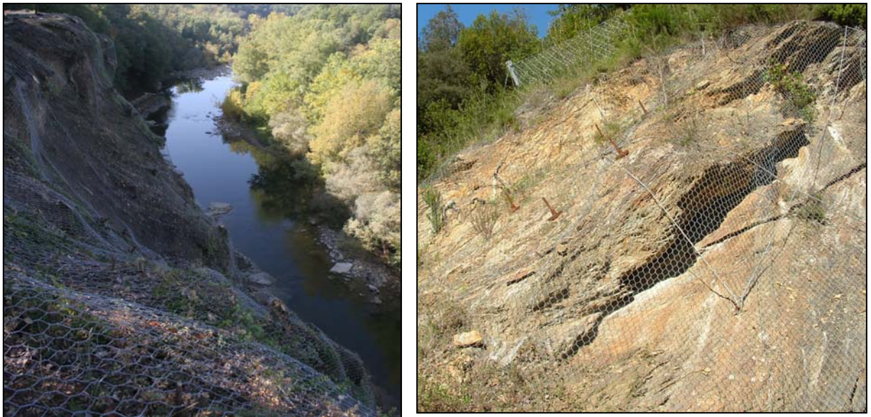
Fig. 129 – A sinistra rivestimento provvisorio, tramite rete esagonale a doppia torsione, di una sponda rocciosa del Fiume Arno in località Borgo a giovì (AR). A destra stabilizzazione di una scarpata rocciosa tramite rete esagonale a doppia torsione rinforzata con un reticolo di funi in acciaio e bullonature (località Seravezza (LU) -
