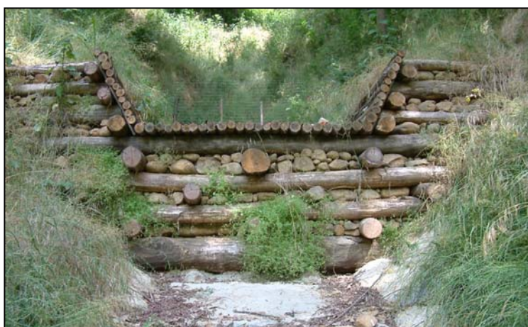
Fig. 118 –Particolare di una briglia in legname e pietrame realizzata nella porzione sommitale di un'impiuvio nei pressi di Reggello (FI) -
