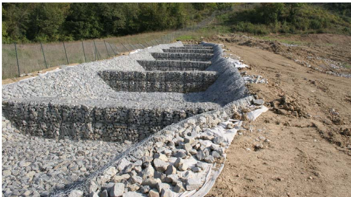
Fig. 40 – Particolare di un fosso di perimetrazione laterale costruito tramite gabbioni e materassi tipo Reno in località Acquatesa nel comune di Barberino di Mugello (FI) nel corso dei lavori connessi con la realizzazione Variante di Valico dell'autostrada A1 -
