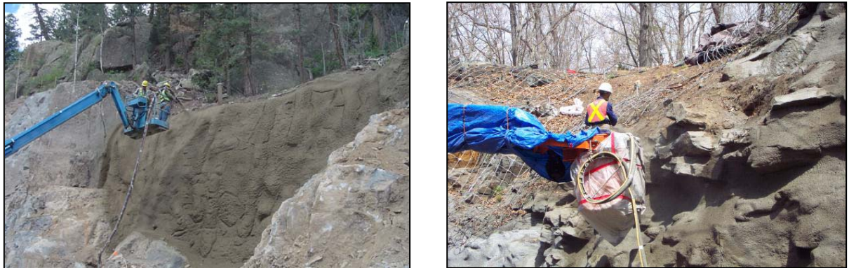
Fig. 103 – Utilizzo di cemento proiettato per la stabilizzazione di pareti rocciose; l'immagine di destra è tratta dal sito internet www.dot.state.co.us (Colorado Department of Transportation), quella di sinistra dal sito www.janod.biz (Janod Inc.) -
