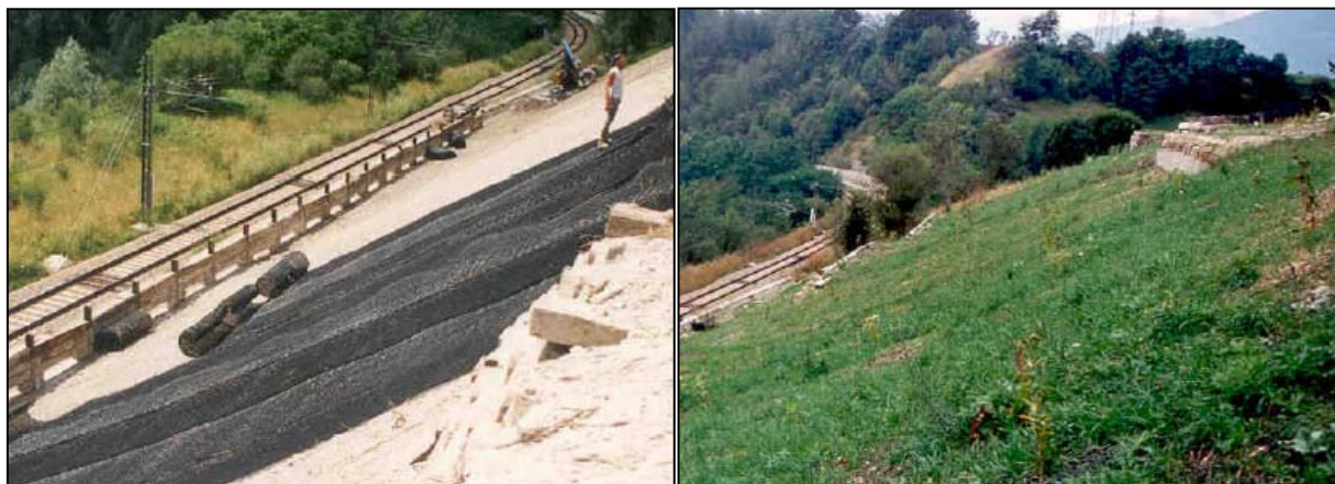
Fig. 13 – Impiego di geostuoia rinforzata con rete metallica, per la stabilizzazione ed il rinverdimento di un versante argilloso: a sinistra fase di posa; a destra situazione dopo l'idrosemina (da ANPA, 2002) -
