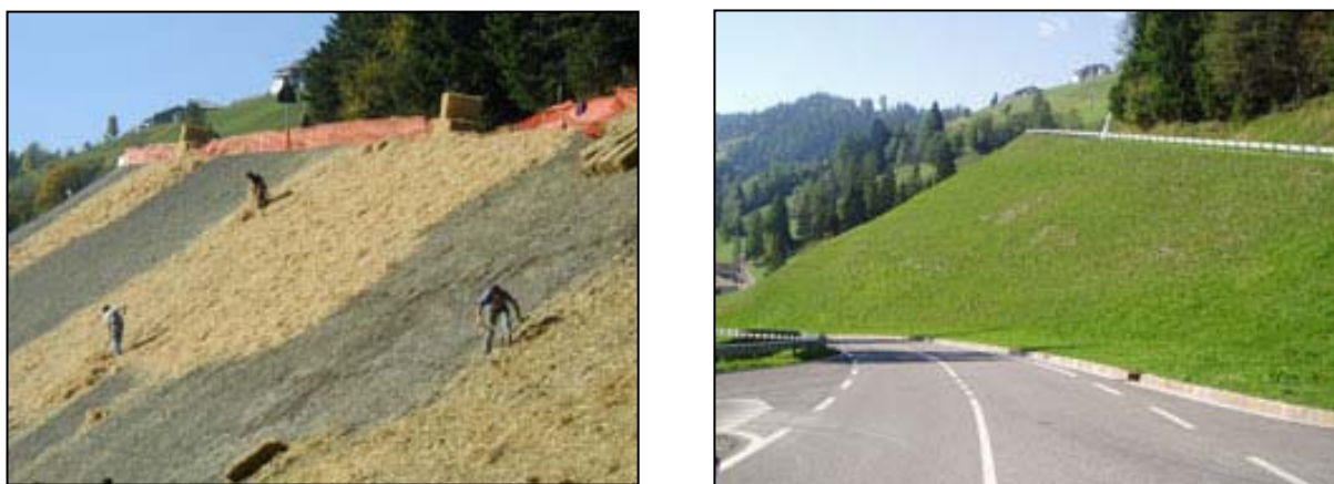
Fig. 18 – Intervento di semina nero-verde su una scarpata a Proves (BZ): a sinistra distribuzione dello strato di paglia e semina, a destra il risultato dopo tre mesi (immagini tratte dal sito internet www.Vandeborre.it ) -
