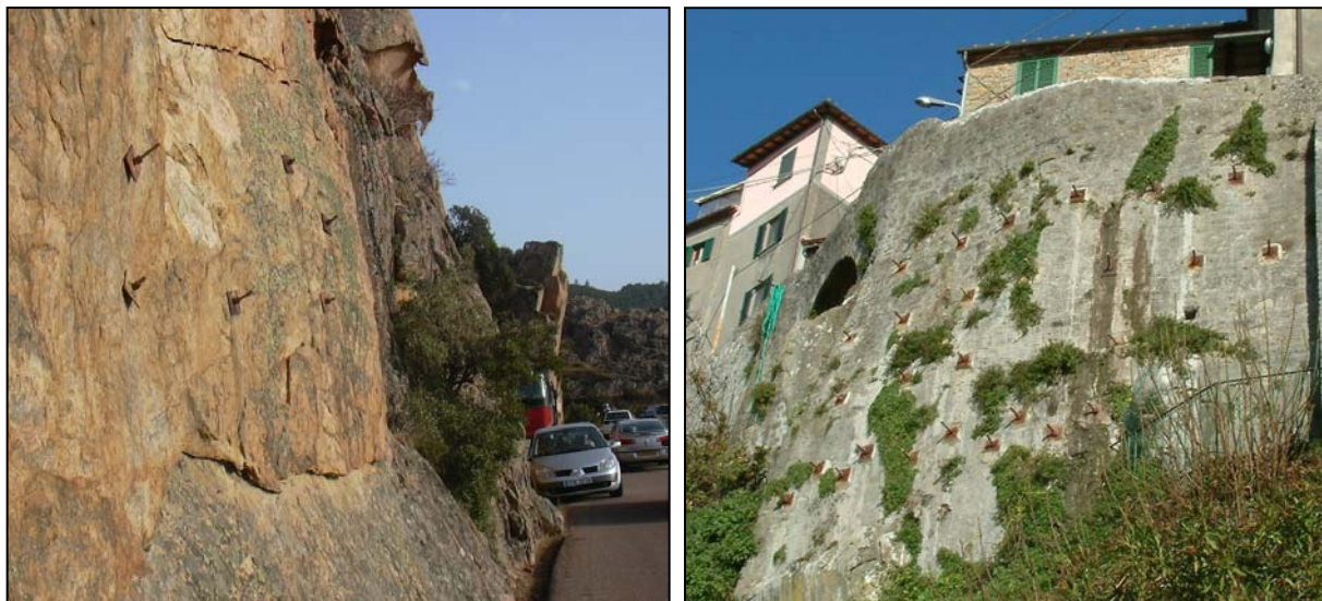
Fig. 97 – A sinistra utilizzo di bulloni per la stabilizzazione di un lastra di granito lungo la strada costiera D81 che collega Porto e Piana nei pressi dei “Calanchi di Piana” in Corsica (Fr). A destra consolidamento di una parete rocciosa tramite bullonatura in località Vellano nel comune di Pescia -
