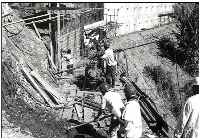
Fig. 90 – Fasi costruttive di muri tirantati. A sinistra muro costruito dal basso verso l'alto: in primo piano fasi di installazione dei tiranti, sullo sfondo posizionamento dell'armatura e muro gettato. A destra muro costruito dall'alto verso il basso: si nota in basso una nicchia scavata e armata; per assicurare la stabilità lo scavo viene effettuato per porzioni limitate, che vengono armate e gettate prima di scavare la porzione limitrofa (da ORTIGAO & SAYAO, 2004) -
